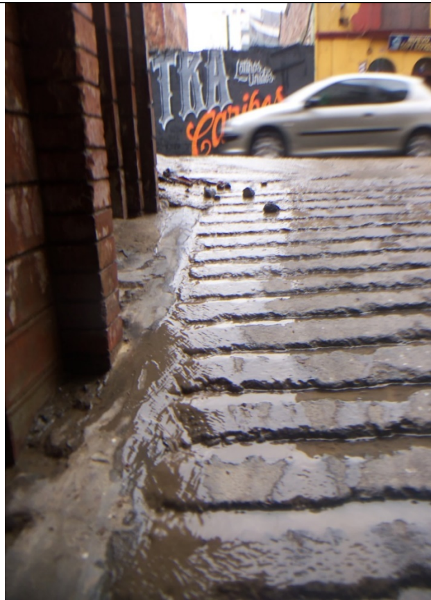
Fotos 18, 19 y 20. Se observó la salida de agua disuelta con sedimentos al espacio público. Así mismo se evidenció la conducción del agua disuelta con sedimentos afectando el sistema de drenaje interno del Edificio Santa Margarita colindante con el predio en construcción.
