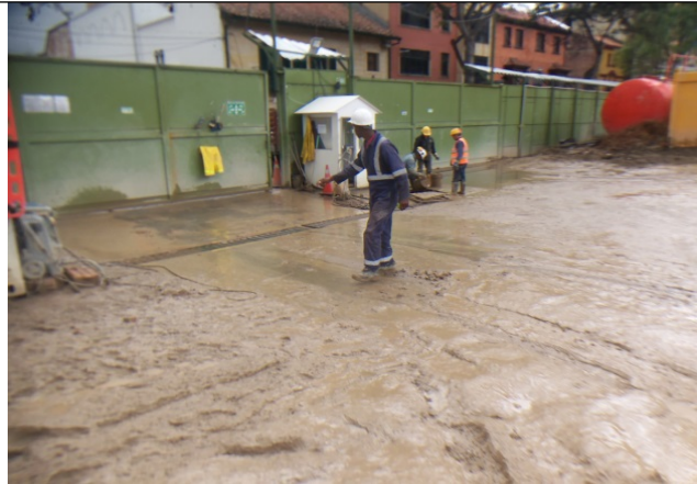
Foto 6 y 7. Se evidenció el arrastre de lodos presentes en la obra a las cajas de sedimentación que trasladan el problema a los componentes del sistema de drenaje urbano.
