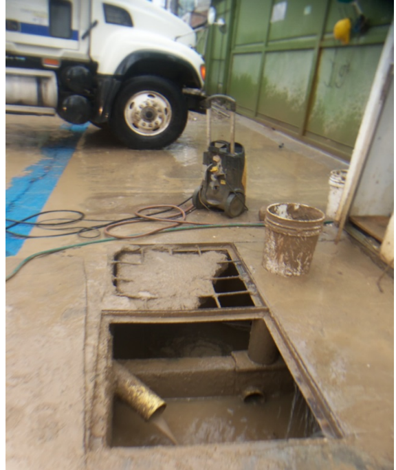
Foto 5. Evidencia del vertimiento de agua con carga de sedimentos disueltos a la caja de inspección ubicada en el espacio público, junto al acceso sur de la Carrera 5 No. 21 – 38.
