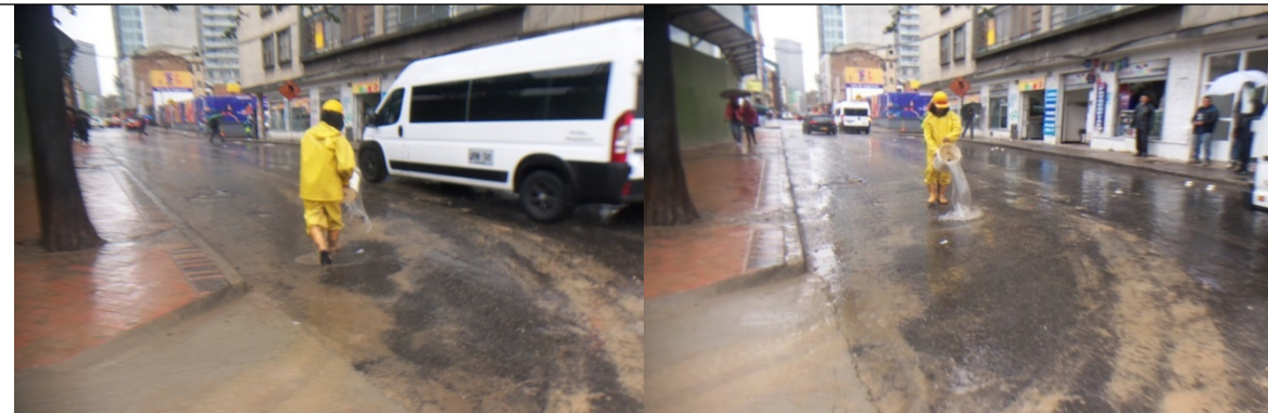
Fotos 16 y 17. Se observa el lavado del espacio público para borrar los rastros de material de arrastre, conducta que va en contra de lo establecido en la norma.
