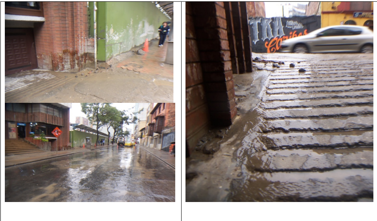
Fotos 18, 19 y 20. Se observó la salida de agua disuelta con sedimentos al espacio público. Así mismo se evidenció la conducción del agua disuelta con sedimentos afectando el sistema de drenaje interno del Edificio Santa Margarita colindante con el predio en construcción.
