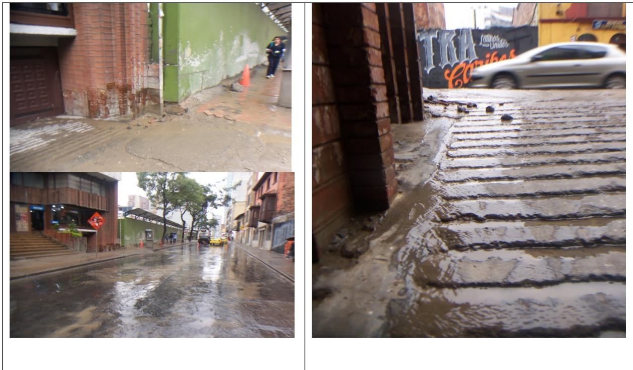
Fotos 18, 19 y 20. Se observó la salida de agua disuelta con sedimentos al espacio público. Así mismo se evidenció la conducción del agua disuelta con sedimentos afectando el sistema de drenaje interno del Edificio Santa Margarita colindante con el predio en construcción.
