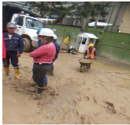
Foto 6 y 7. Se evidenció el arrastre de lodos presentes en la obra a las cajas de sedimentación que trasladan el problema a los componentes del sistema de drenaje urbano.
